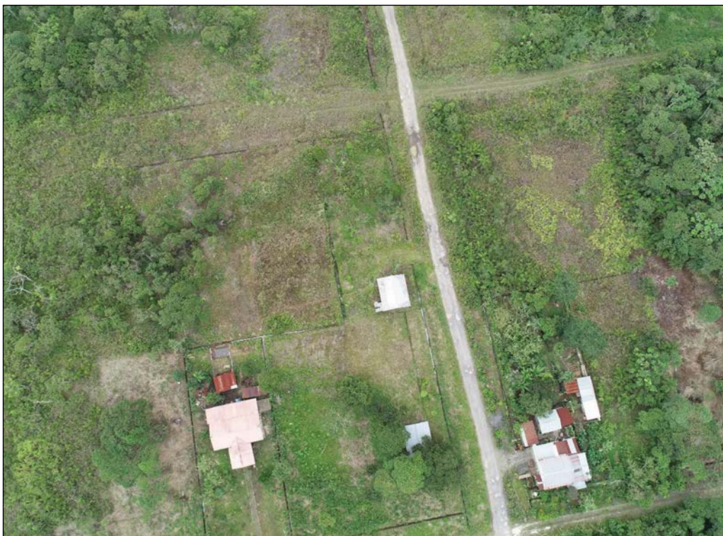
Figura 4.8. Fotografías en detalle de la Zona norte
