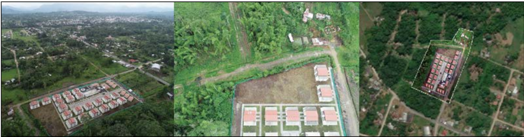
Figura 4.14. Fotografías panorámicas del proyecto de vivienda Casa para Todos de Sucúa
