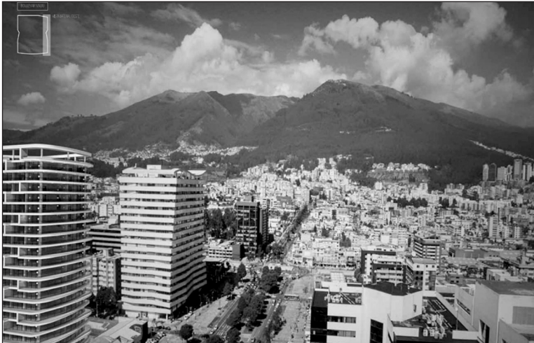
Fotografía 2. Edificios corporativos One Naciones Unidas y Metropolitan
