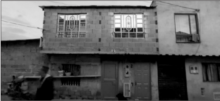
Figura 8: Fachada Vivienda Actual
