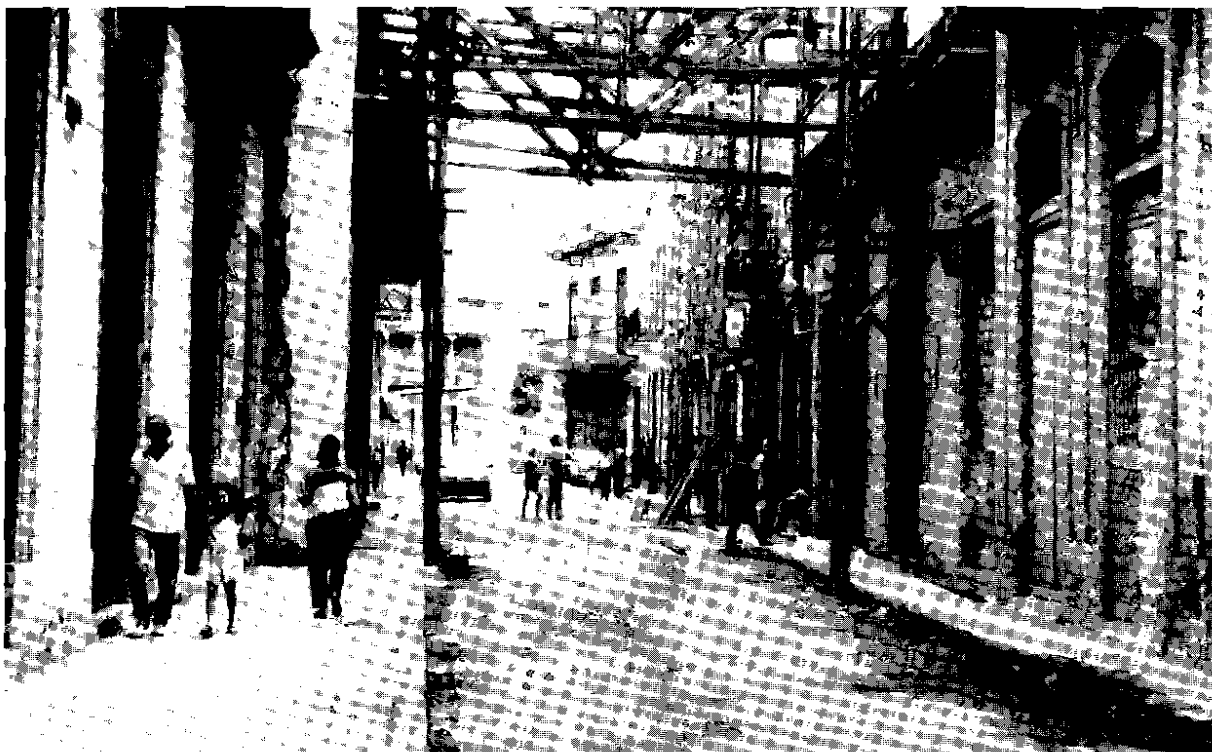
Trabajos de apuntalamiento y consolidación después del huracán. La Habana, Cuba
